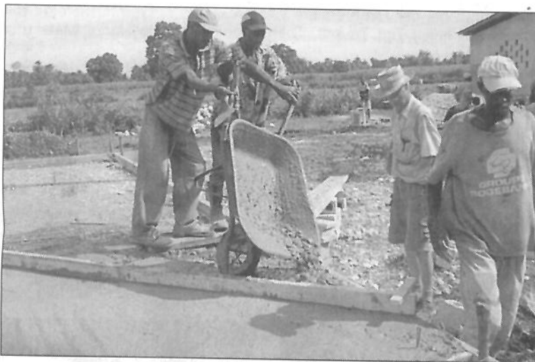
Die Bauarbeiten am Ausbildungszentrum für Handwerksberufe in Haiti schreiten weiter voran. 90 000 Euro fließen in dieses Großprojekt.
